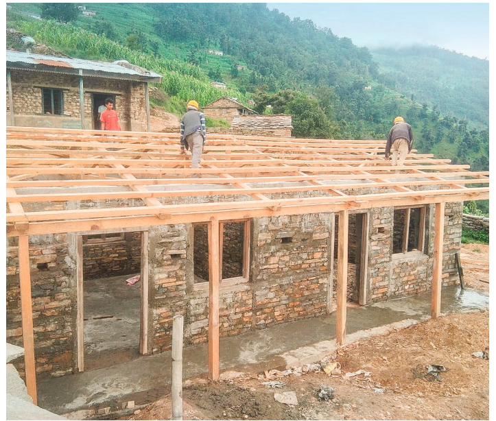
Die Baumaßnahmen an den Projektschulen machen gute Fortschritte.
